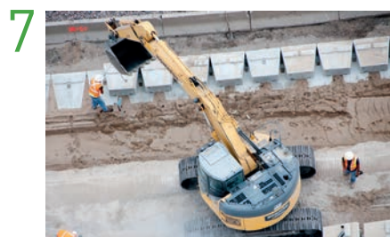
Extra lagen plaatsen, zelfdragende keermuur
