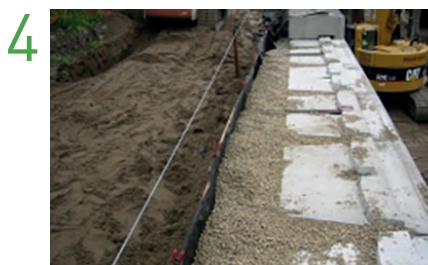
Het drainagemateriaal plaatsen
