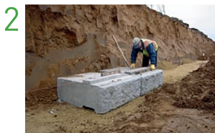
De basisblokken plaatsen en nivelleren
