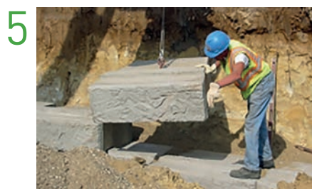
Lagen plaatsen, zelfdragende keermuur
