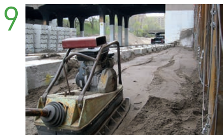
Aanvullen en verdichten
