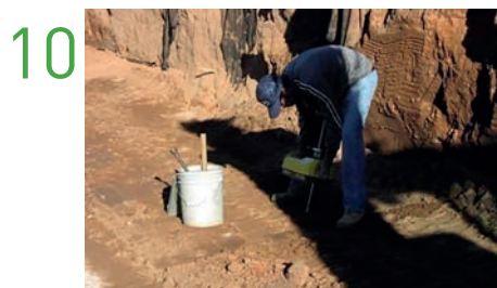
Verdichting regelmatig controleren
