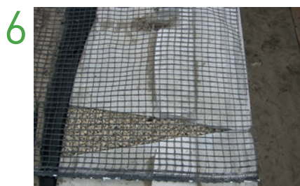
Geogrid plaatsen (indien vereist)
