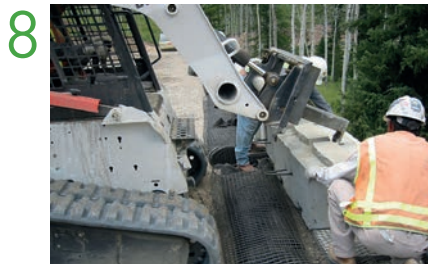
Extra lagen plaatsen, geogrid keermuur
