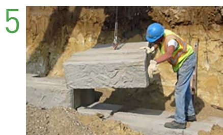
Lagen plaatsen, zelfdragende keermuur
