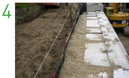
Het drainagemateriaal plaatsen
