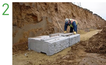
De basisblokken plaatsen en nivelleren
