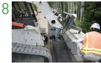
Extra lagen plaatsen, geogrid keermuur
