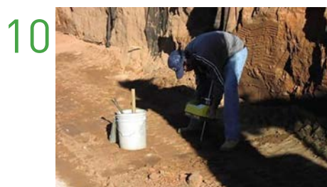
Verdichting regelmatig controleren
