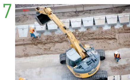
Extra lagen plaatsen, zelfdragende keermuur
