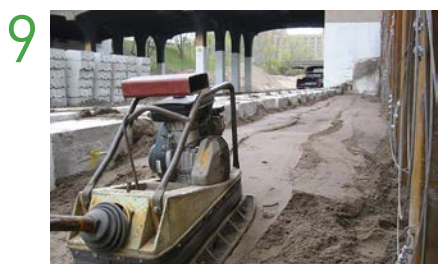
Aanvullen en verdichten
