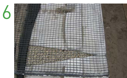
Geogrid plaatsen (indien vereist)
