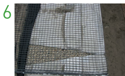
Mise en place du géotextile (si exigé)
