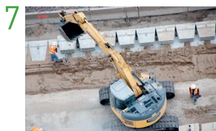
Mise en place des couches supplémentaires, mur de soutènement autoportant
