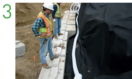
Mise en place de la natte filtrante
