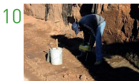
Contrôler régulièrement le compactage
