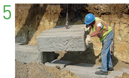
Mise en place des couches, mur de soutènement autoportant
