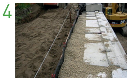
Mise en place du matériau de drainage
