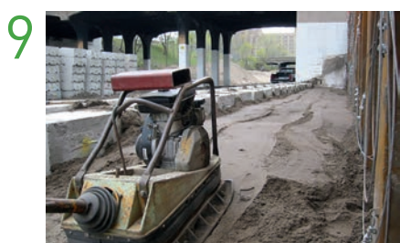
Remblayage et compactage
