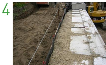
Mise en place du matériau de drainage
